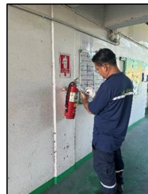
ภาพที่ 34 ตรวจสอบอุปกรณ์ดับเพลิง
